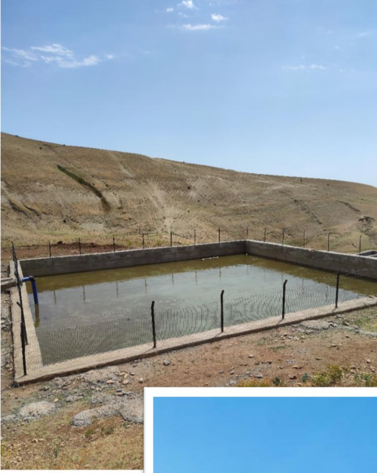
Merkez Yüce-tepe Köyü Sulama Havuzu Bakım ve Onarımı
