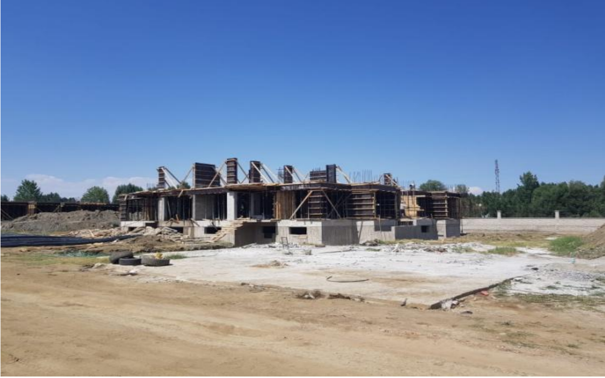
Muş İl Emniyet Müdürlüğüne Bağlı Muş Merkez 112 Daireli Lojman İnşaatı Yapımı ve Çevre Düzenlemesi İşi
