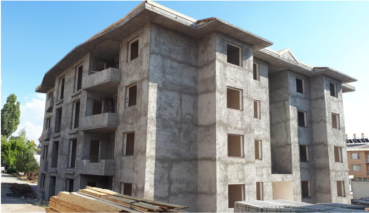
Muş Merkez Polis Merkezi Amirliği ve 1 Adet Lojman İnşaatı Yapımı, Altyapı ve Çevre Düzenlemesi İşi
