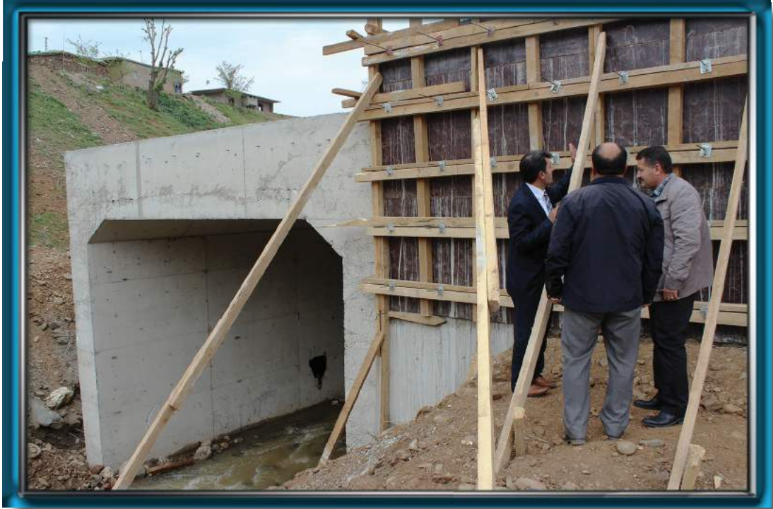
KANTARA köprüsü yapımı
